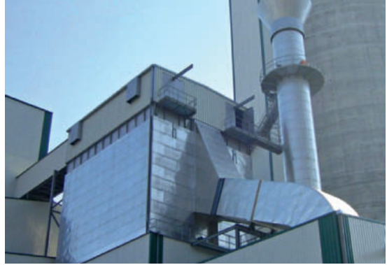
13 Schlauchfilter zur Zementmühleneinstaubung
