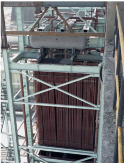
10 Abwärmekessel während der Montage. Rohrbündel und Dampftrömmel
