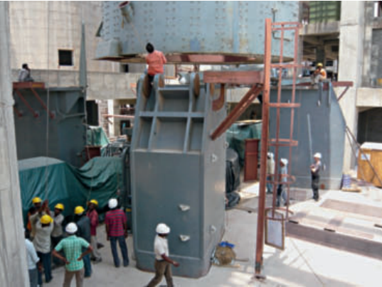
7 Montage des Mühlengehäuses (Balaji, Indien)
