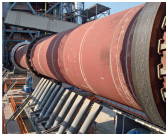
4 KHD Drehrohrofen. 3 Lagerstationen, mit Zahnkranztrieb und Sinterzonenkühlung
