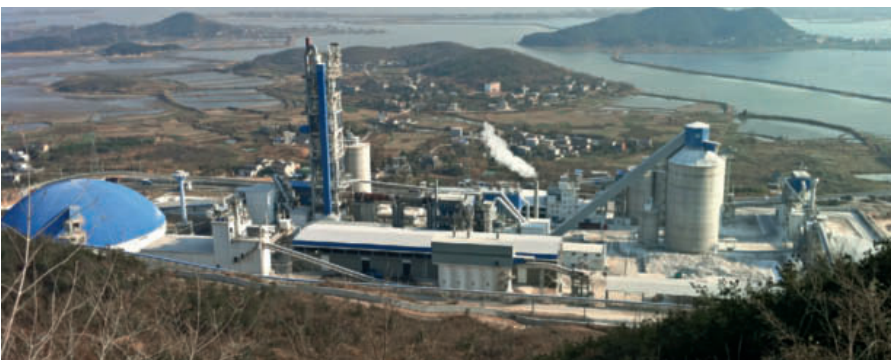
1 5-stufiger Vorwärmer/Vorkalzinerierofen
