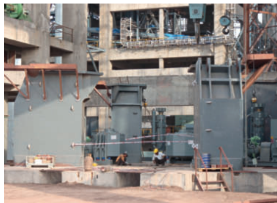
6 Die montierten Stützen der MVR im Werk Balaji (Indien)
