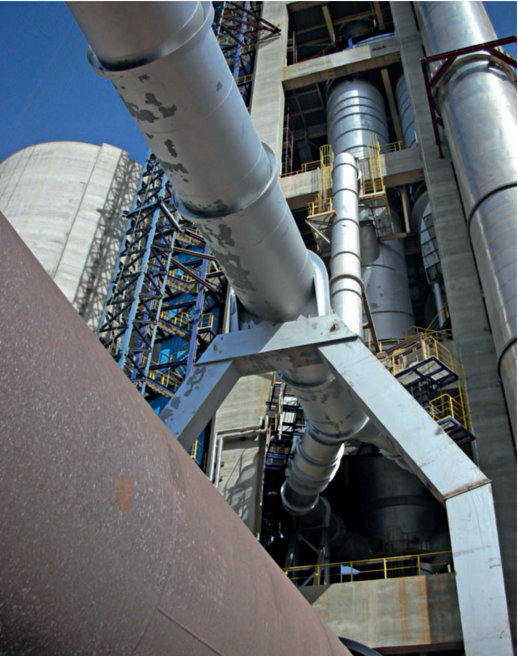
3 Blick auf einen Vorwärmerturm mit Tertiärluftleitung und Drehrohren
