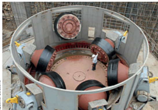
4 Vertikalmühle (Bau) zur Rohmaterialvermahlung
