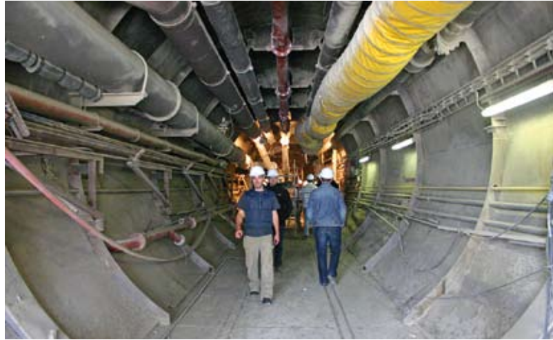
10 Fuel feed lines • Brennstoffzuleitungen
