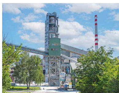
10 Čížkovice cement plant
