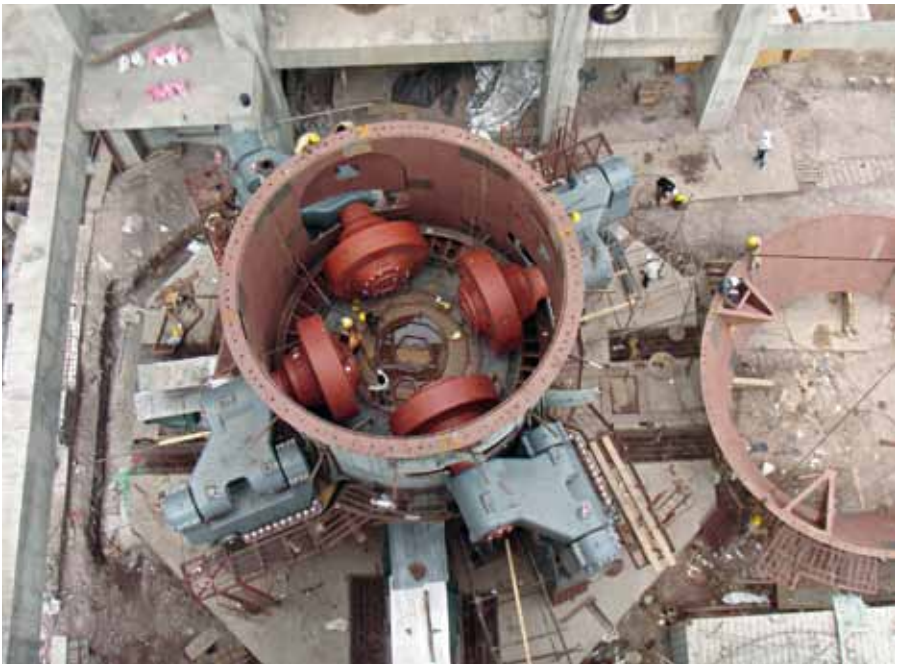
8 Montierte Walzenmodule (Balaji, Indien)
