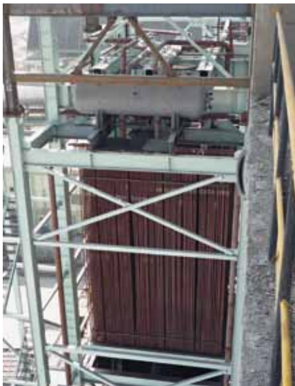
10 Abwärmekessel während der Montage. Rohrbündel und Dampftrömmel
