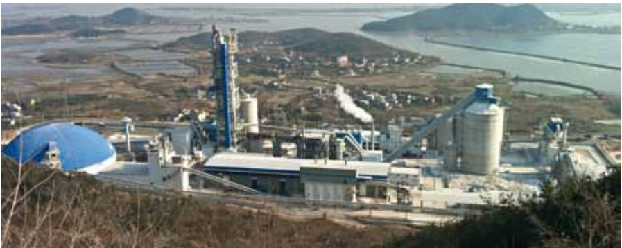
1 5-stufiger Vorwärmer/Vorkalzinerierofen
