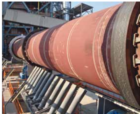
4 KHD Drehrohrofen. 3 Lagerstationen, mit Zahnkranzantrieb und Sinterzonenkühlung
