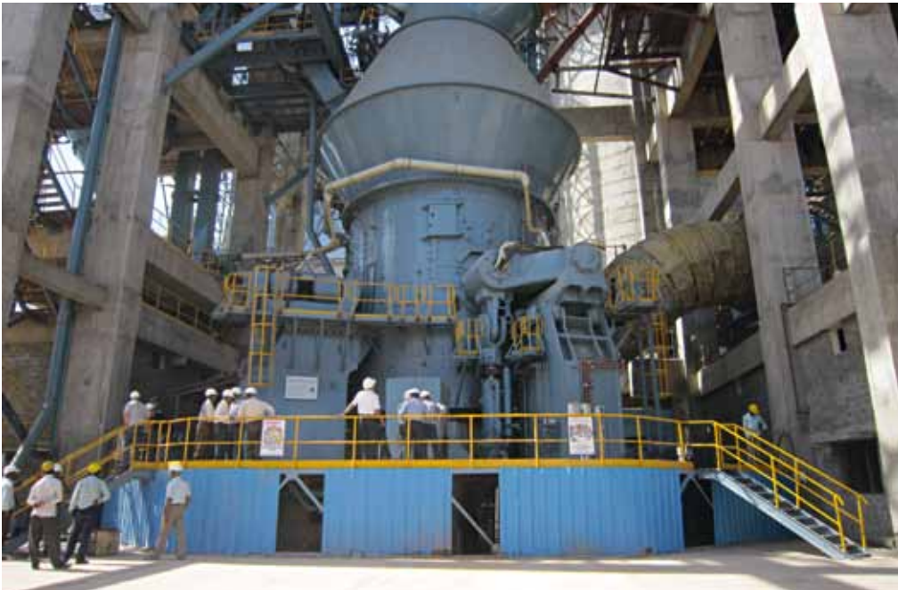
10 Die MVR 5600 C-4 im Werk Balaji (Indien) im Juni 2012 nach Inbetriebnahme
