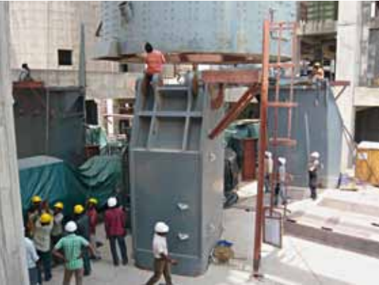
7 Montage des Mühlengehäuses (Balaji, Indien)
