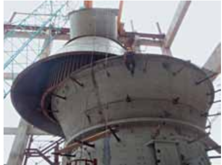
9 Montage des Siehteroberteils (Balaji, Indien)
