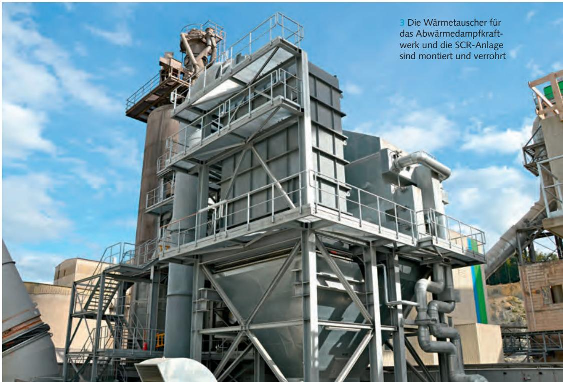
3 Die Wärmetauscher für das Abwärmekraftwerk und die SCR-Anlage sind montiert und verrohrt
